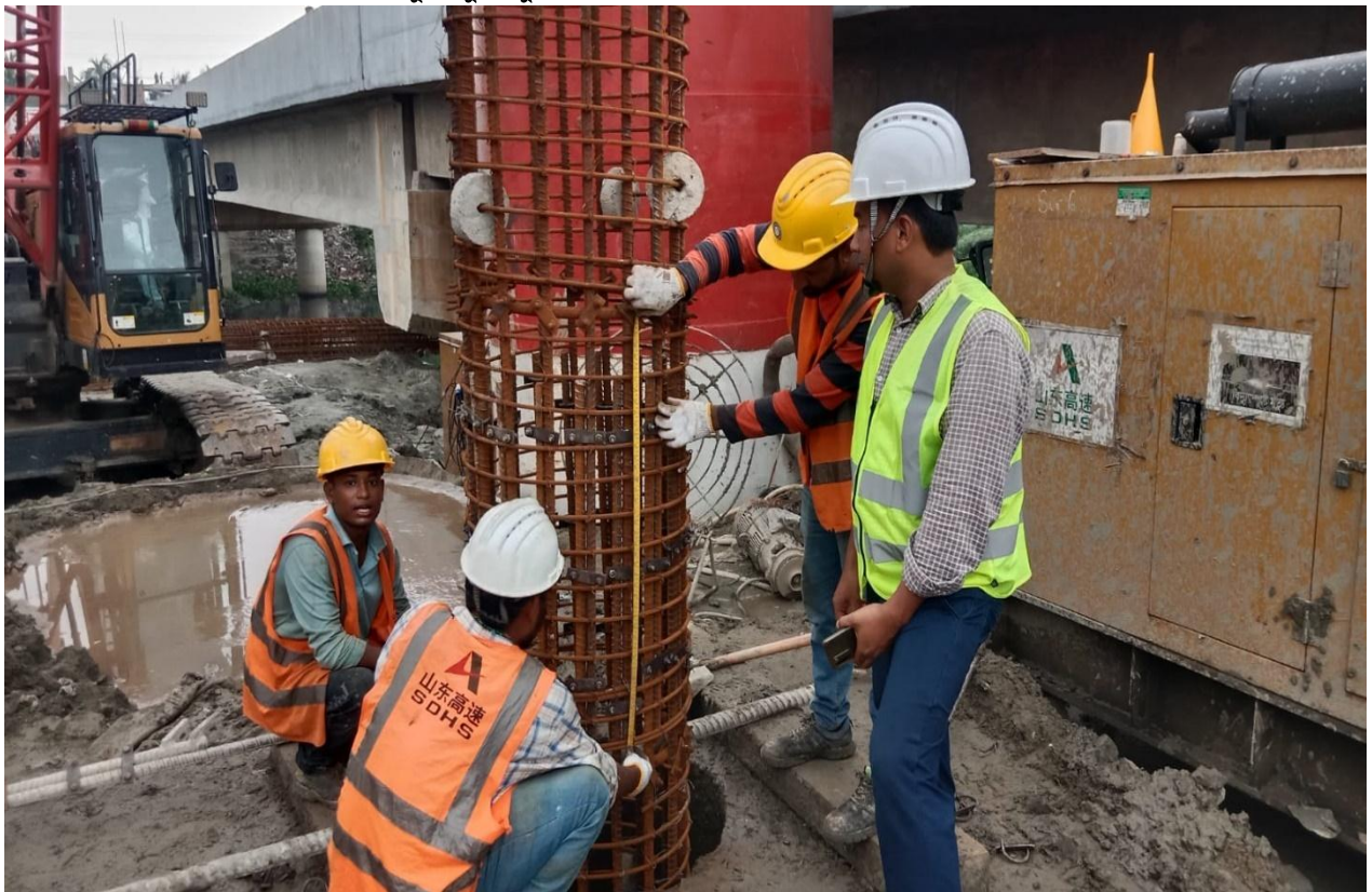
পঞ্চবাট হতে মুক্তারপুর সেতু পর্যন্ত সড়ক প্রশস্তকরণ ও দোতলা রাস্তা নির্মাণ প্রকল্পের ভৌত কাজ
